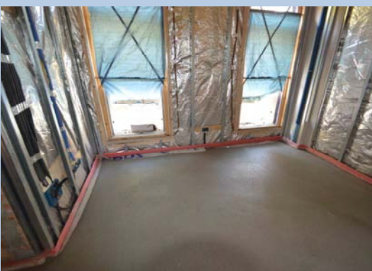
Posa impianti elettrici e massetti
