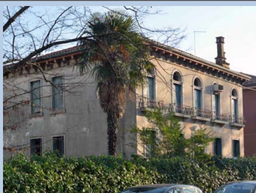
Esterno della villa prima dei lavori
