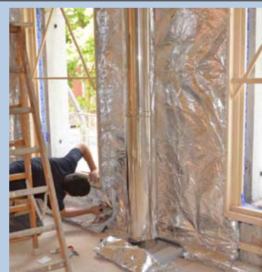
Fissaggio di Over-foil Multistrato 19
