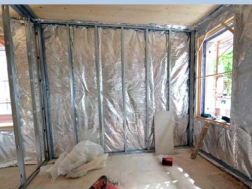
Posa della struttura per cartongesso
