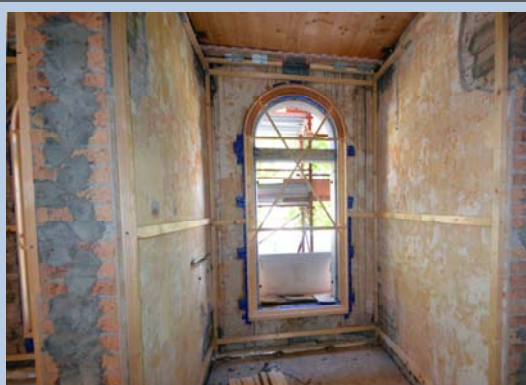
Posa dei listelli di legno sulle pareti
