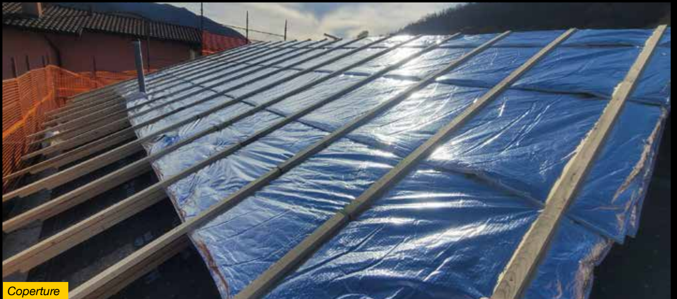
Contropareti interne e Controsoffitti
