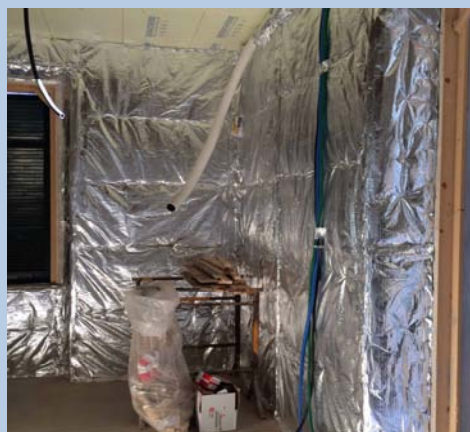
Parete isolata con Over-foil Multistrato 19
