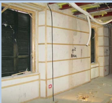
Posa dei listelli di legno sulle pareti
