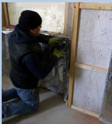
Dettaglio di fissaggio dell'isolante ai listelli
