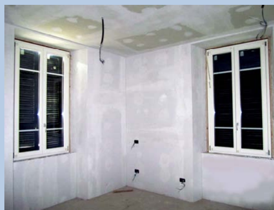
Contropareti in gesso rivestite posate e stuccate
