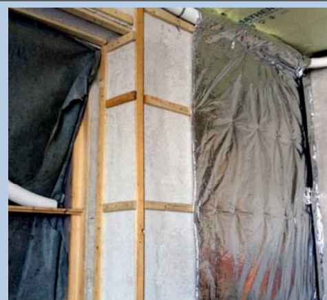
Fissaggio dell'isolante Over-foil Multistrato 19
