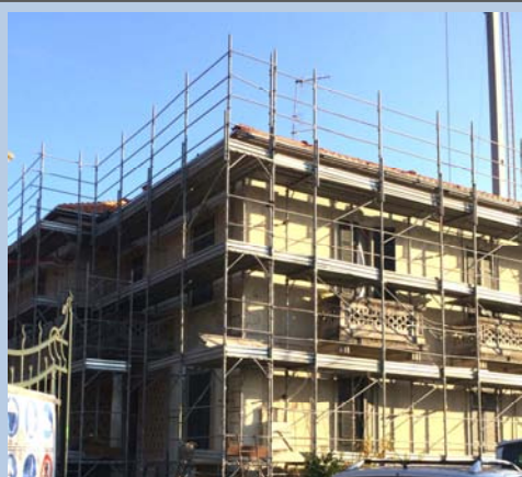
Esterno della villa durante i lavori
