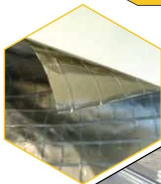
**Miofol® 125 AV** è un foglio laminato a strati costituito da un foglio di LDPE, accoppiato ad un foglio di alluminio rivestito e protetto a sua volta da un foglio di polietilene dello spessore di 11 µm. Miofol® 125 AV viene utilizzato come barriera al vapore sotto pavimento e in tetti a falda, tetti piani e nelle pareti. Per ottenere le migliori prestazioni del prodotto si raccomanda di sigillare tutte le giunte per mezzo dell'apposito nastro adesivo in alluminio.
