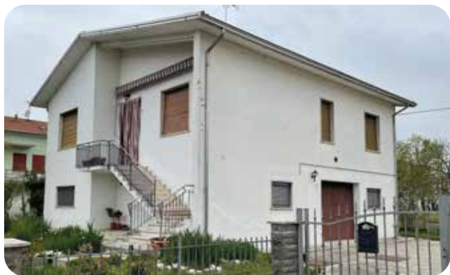
• Vista esterna pre intervento
