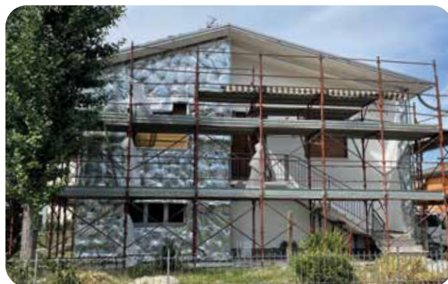
• Posa primo strato isolante Over-foil Multistrato 19
