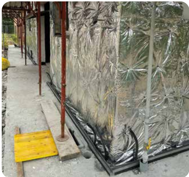
• Posa primo strato isolante Over-foil Multistrato 19
