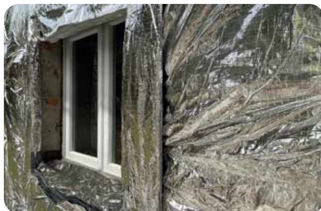
• Posa secondo strato isolante Over-foil Multistrato 19
