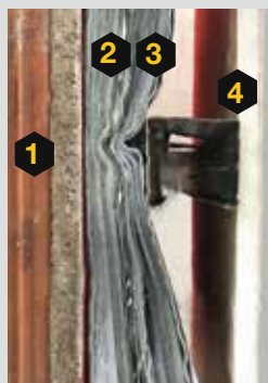
Sezione A-A - Controparete vista dall'alto
